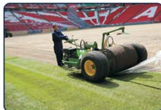
УСТРОЙСТВО НАТУРАЛЬНОГО ГАЗОНА (ПОСЕВ, НАСТИЛ)
