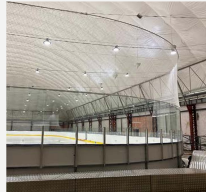
Хоккейный борт ограждения с защитным остеклением
